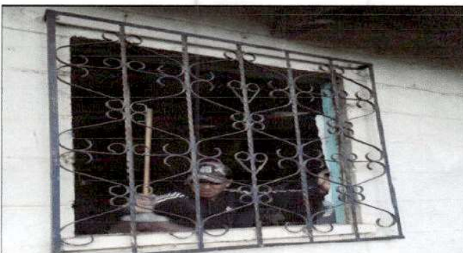
Foto 4: Instalación de Ventanas por metal mas vidrio.
