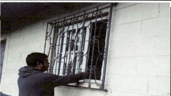
Foto 5: Sustrucción de ventanas, por ventanas de metal y vidrio.
