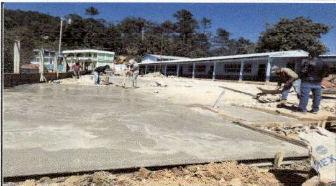
Foto1: Sustrucción de plancha de concreto en el patio de la Escuela.
