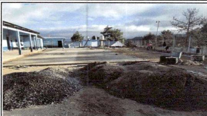
Foto 2: Colocación de torta de concreto patio de la Escuela.
