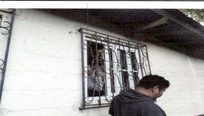
Foto 6: Instalación de ventanas.
